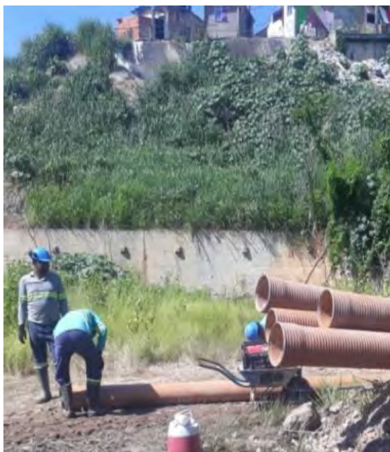
Foto 6 - Lançamento de tubulação provisória.
