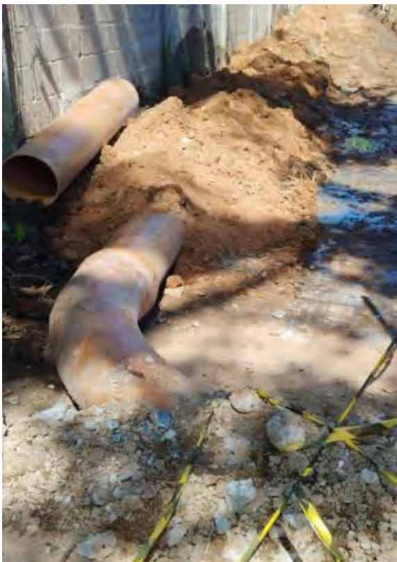
Foto 9 - Lançamento de tubulação
