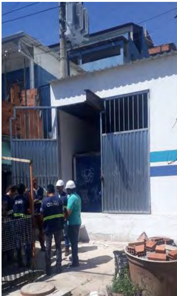
Foto 1 - EEA (Estação Elevatória de Água
