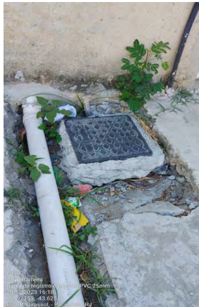
Foto 16- Cx de registro e tubo PVC de 25mm
