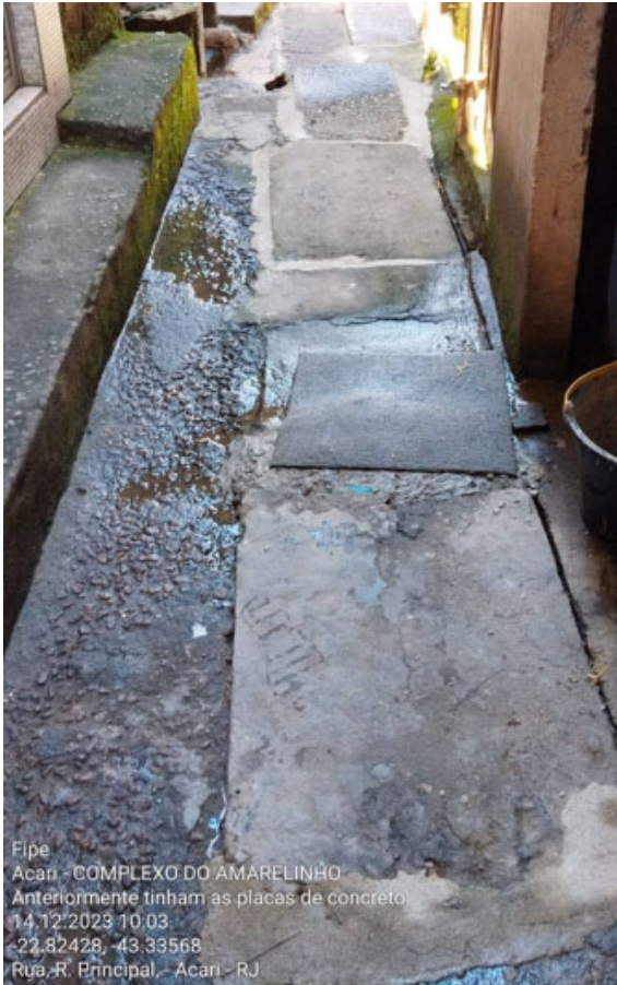
Foto 3 - Local onde ainda não foi realizada a pavimentação
