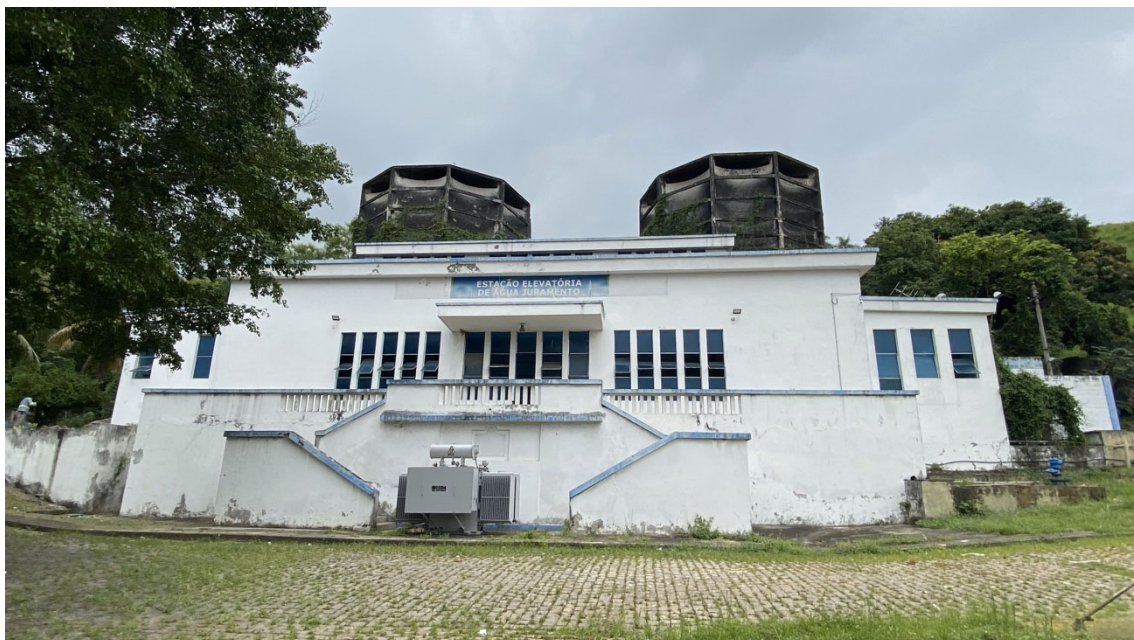
Foto 16 - Estação Elevatória de Água Juramento
