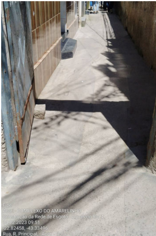
Foto 1 - Canalização e Pavimentação – Rede de esgoto
