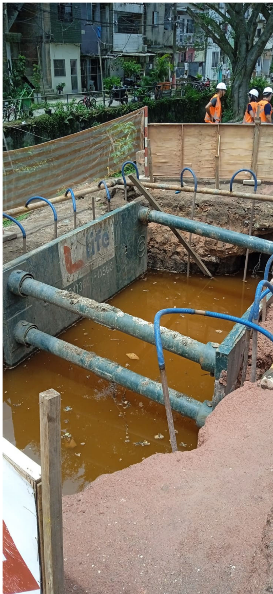
Foto 6 - Construção da EEE.
