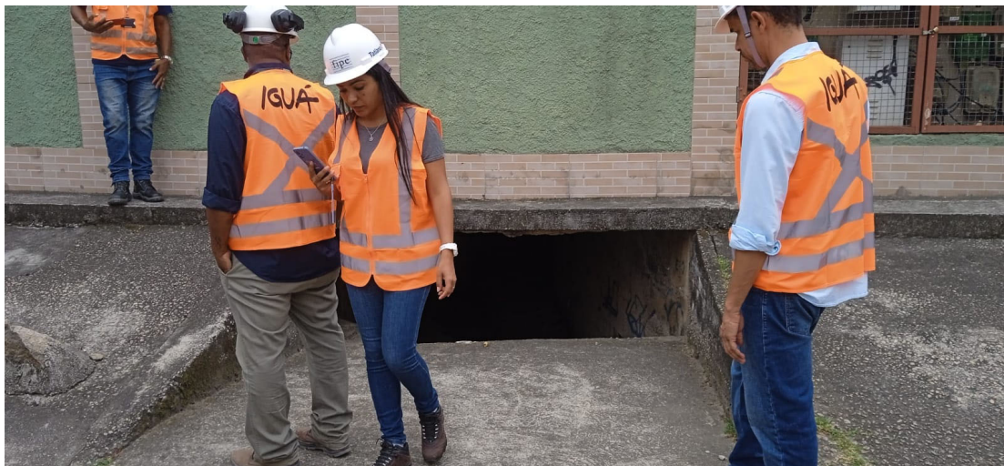
Foto 2 - Canal de esgoto na rua Aruti.
