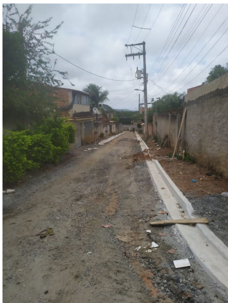
Foto 7 - Rede de água já assentada
