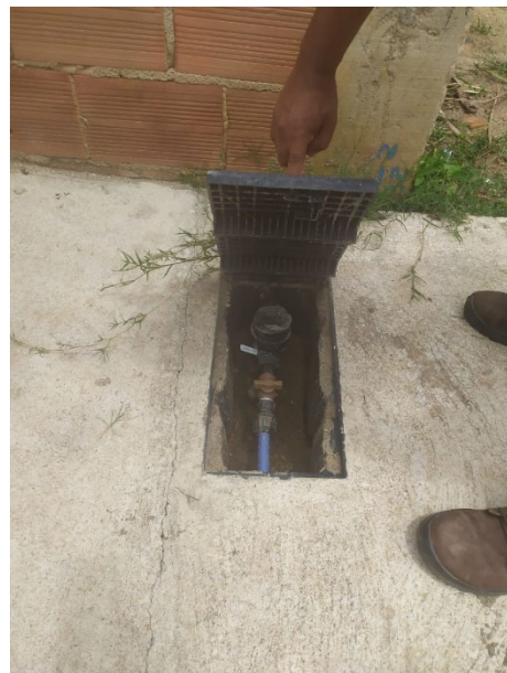
Foto 6 - Instalação de hidrômetro
