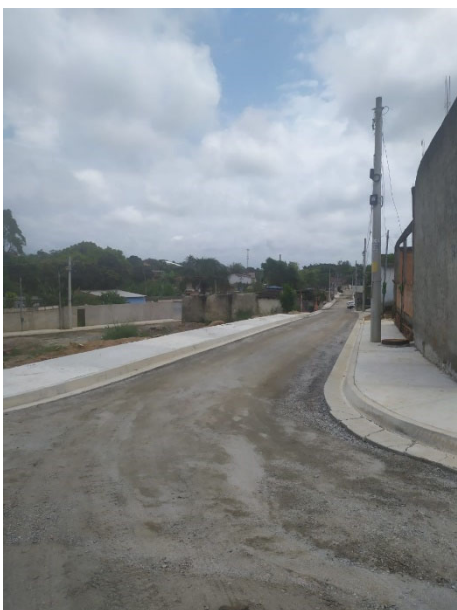
Foto 1 - Rede de água já assentada
