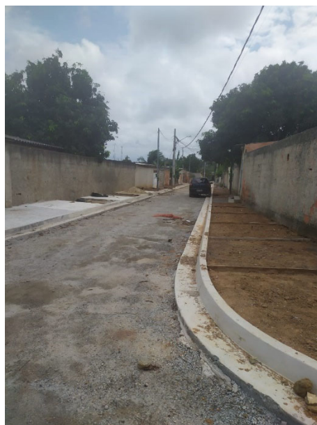
Foto 2 - Rede de água já assentada
