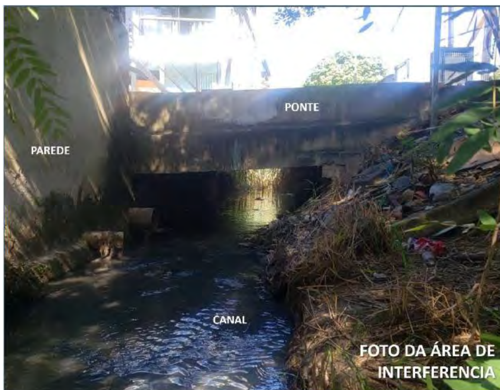
Figura 17 - Canal de drenagem existente – Vista 01 – AF-CAF-05
