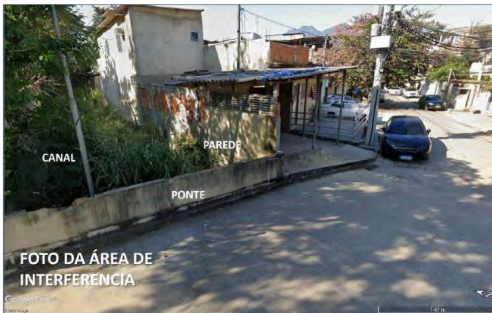
Figura 18 - Canal de drenagem existente – Vista 02 – AF-CAF-05
