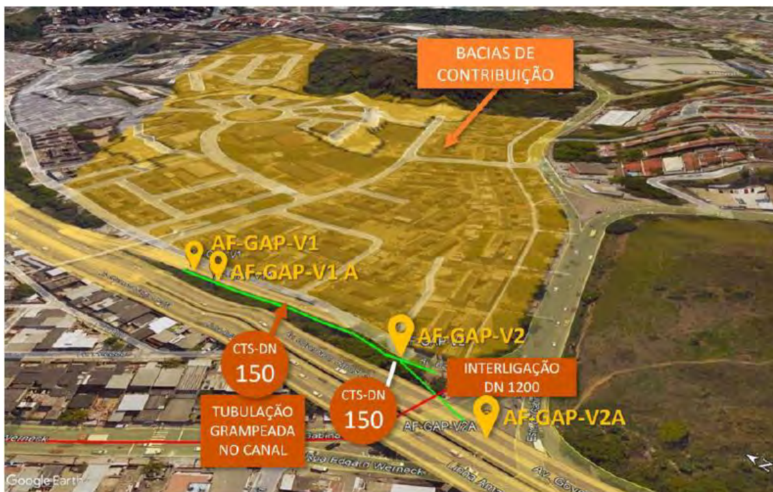
Figura 40 - Área de atendimento e situação – AF-GAP-V1, AF-GAP-V1A, AF-GAP-V2 e AF-GAP-V2A
