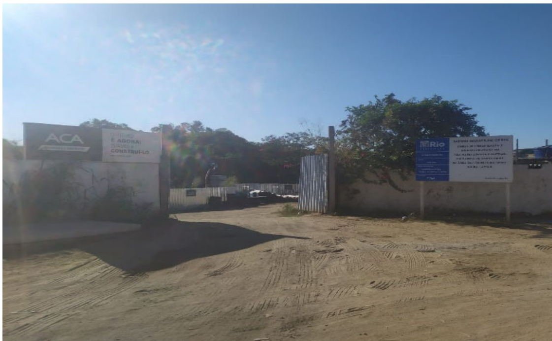
Foto 2: Canteiro de obras da Concessionária Rio +
