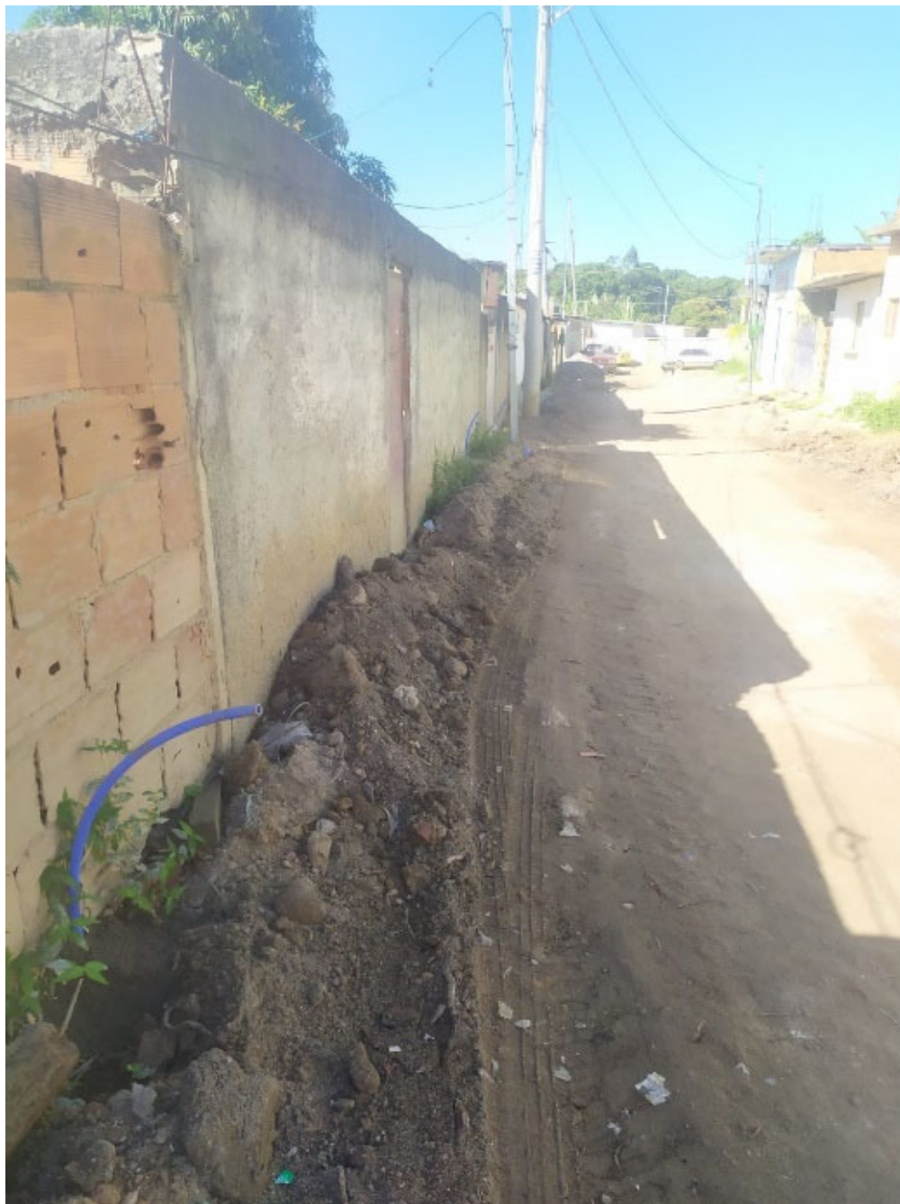
Foto 4: Trecho com a rede subterrânea já lançada e coberta com aterro, com os pontos de distribuição (tubulação azul) à espera do calçamento para instalação dos hidrômetros e ligação com os domicílios.
