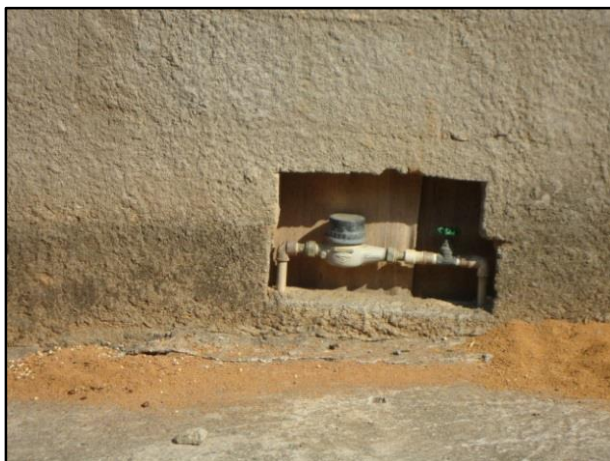
Figura 21 – Ligação com hidrômetro
