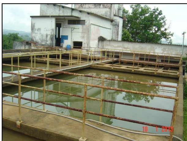
Figura 14 – Vista da ETA Centro
