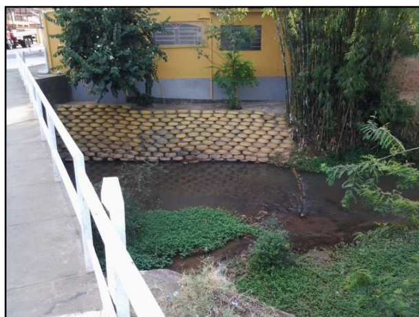
Figura 31 – Contenção de paliçada de pneus
