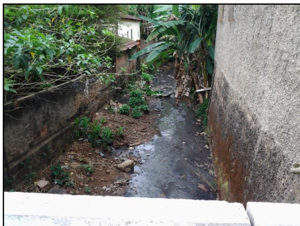
Figura 28 – Córrego que recebe águas pluviais
