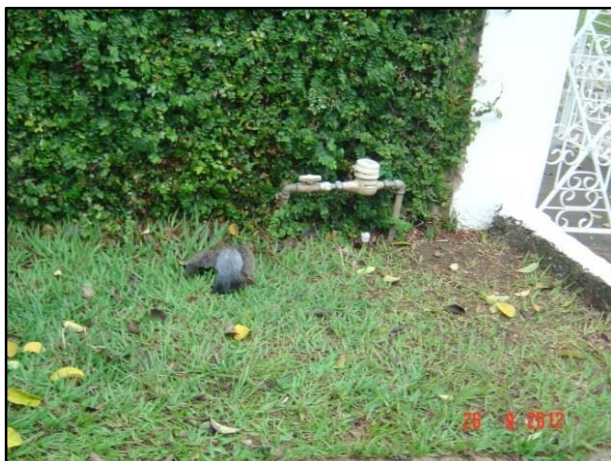
Figura 22 – Ligação com hidrômetro
