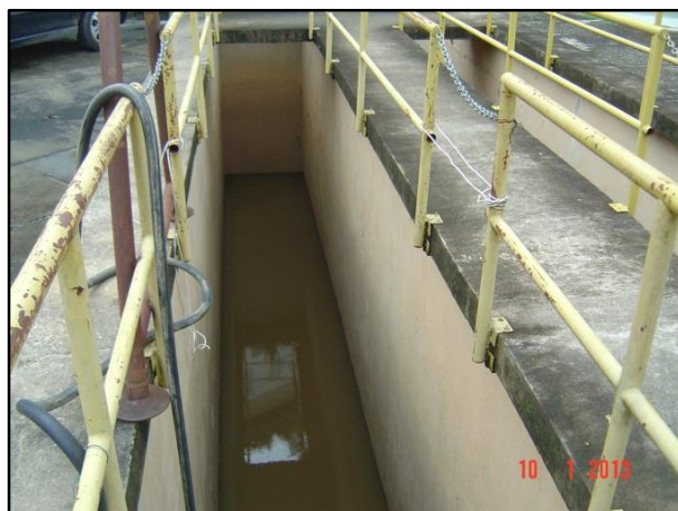
Figura 11 – Captação da EEAB
