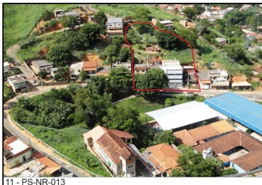
Figura 36 - Área de risco no bairro Pq. Morone na Rua Venezuela
