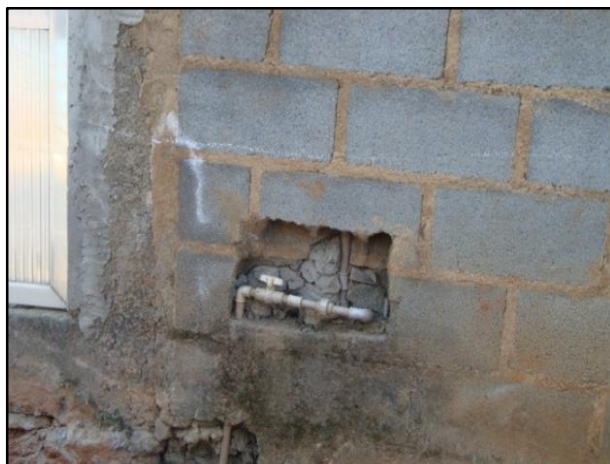
Figura 19 – Ligação com pena d'água
