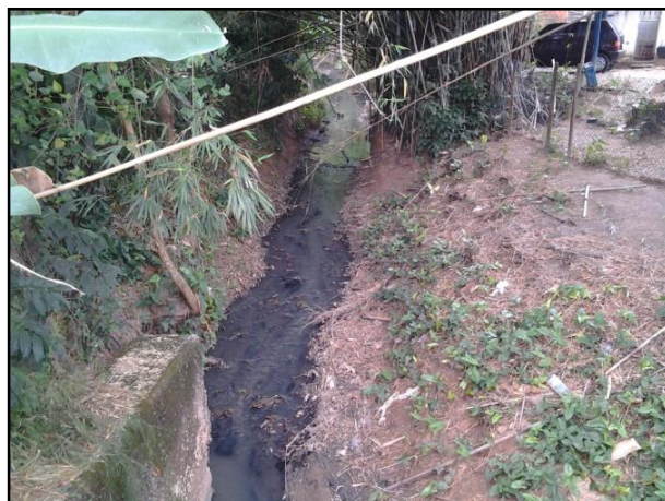
Figura 29 – Córrego que recebe águas pluviais
