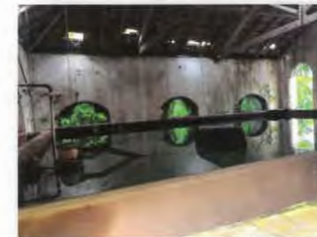
FIGURA 1.63 – RESERVATÓRIO LIMOEIRO - SISTEMA PRINCIPAL
