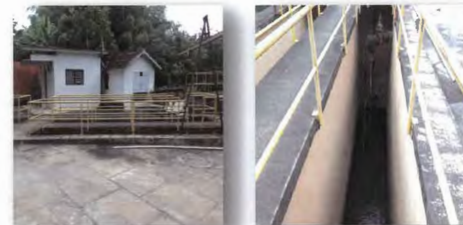
FIGURA 1.18 – CANAIS DE APROXIMAÇÃO DA CAPTAÇÃO – SISTEMA PRINCIPAL
