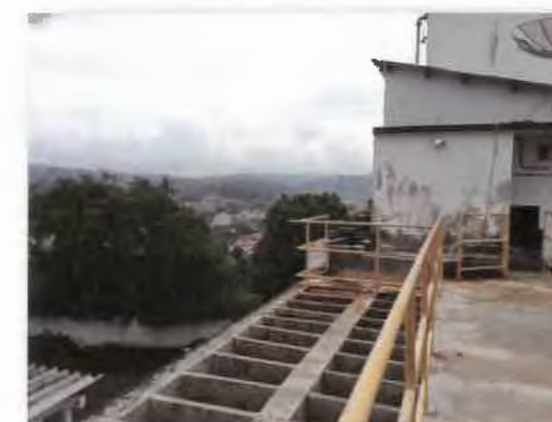
FIGURA 1.37 – FLOCULADOR HIDRÁULICO DE FLUXO VERTICAL
