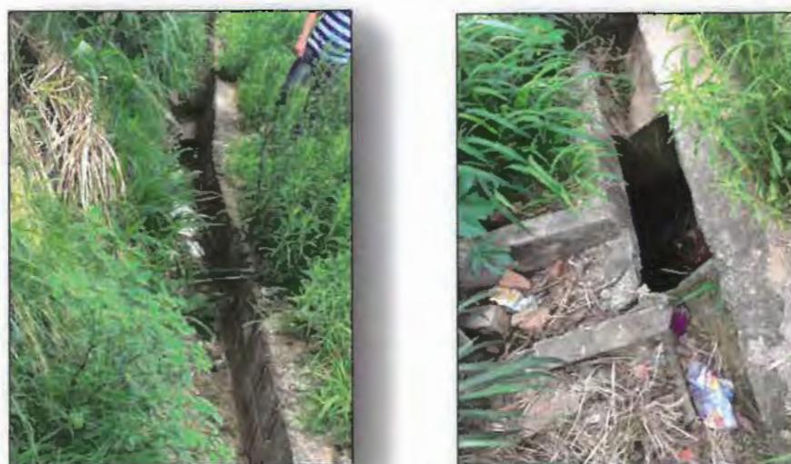
FIGURA 2.14 – LANÇAMENTO DE ESGOTO IN NATURA NA REDE PLUVIAL
