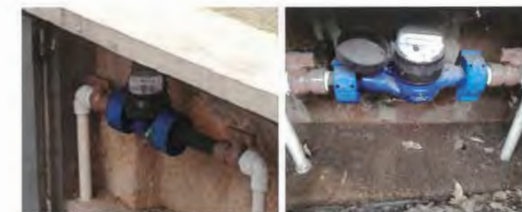
FIGURA 1.102 – CAVALETES CONSTRUÍDOS DE FORMA ADEQUADA
