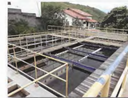
FIGURA 1.40 – EM PRIMEIRO PLANO, VISTA DOS DECANTADORES E AO FUNDO, VISTA DOS CANAIS DE DISTRIBUIÇÃO PARA ALIMENTAÇÃO DOS DECANTADORES
