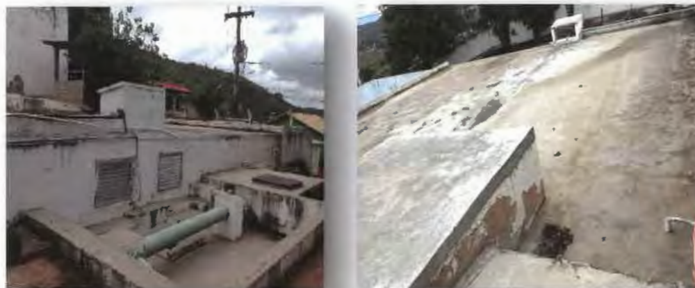
FIGURA 1.62 – RESERVATÓRIO ETA CENTRO - SISTEMA PRINCIPAL
