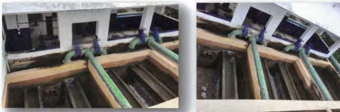
FIGURA 1.42 – FILTROS RÁPIDOS DE FLUXO DESCENDENTE
