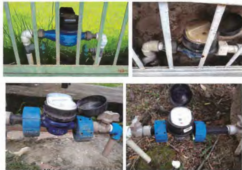
FIGURA 1.104 – CAVALETES COM MATERIAL MISTO E SEM LACRE DE VIROLA E CAVALETES SEM ABRIGO DE PROTEÇÃO
