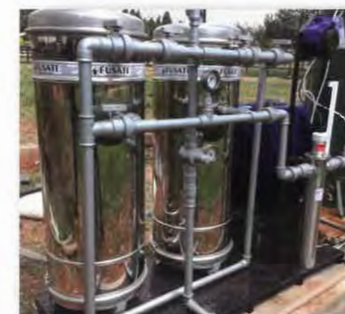
FIGURA 1.61 – EXEMPLO DE SISTEMA DE TRATAMENTO DE ÁGUA SUBTERRÂNEA
