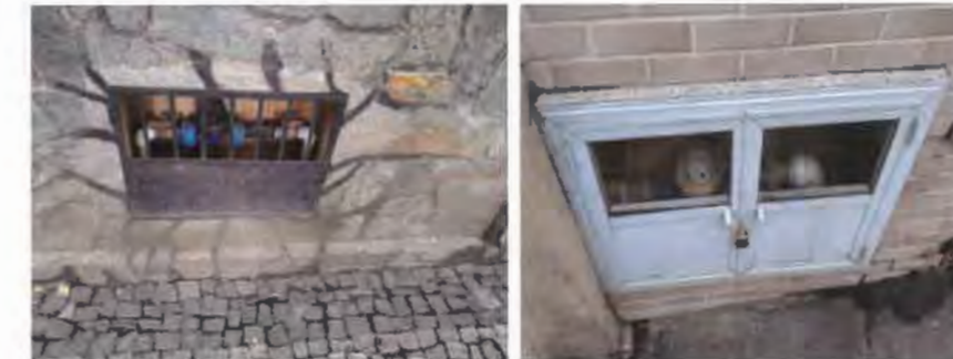
FIGURA 1.101 – PADRÃO DE ABRIGO PARA HIDRÔMETRO
