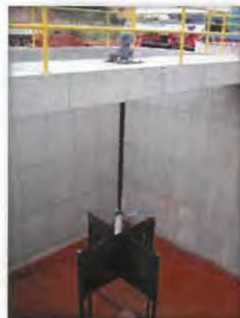
FIGURA 1.55 – EXEMPLO DE UMA CÂMARA DE FLOCULAÇÃO DOTADA DE FLOCULADOR MECANIZADO DO TIPO TURBINA DE FLUXO
