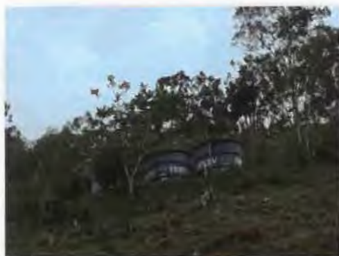
FIGURA 1.70 – RESERVATÓRIO LIMOEIRO - SISTEMA INCONFIDENCIA
