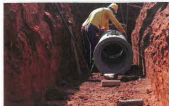
FIGURA 2.10 – IMPLANTAÇÃO DE COLETOR TRONCO
